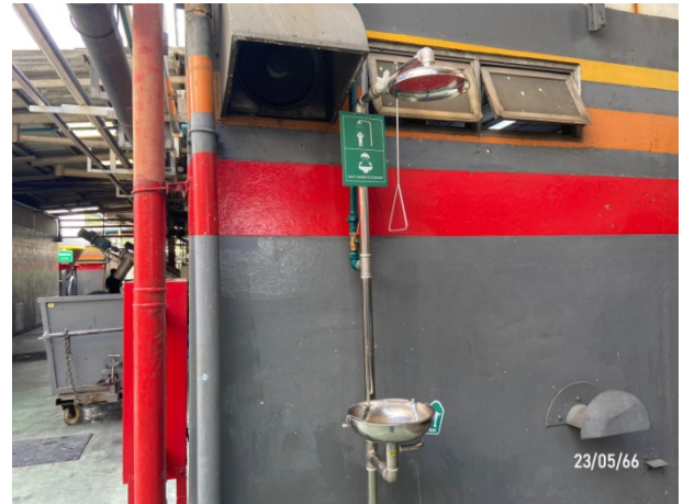
รูปที่ 3-10 อ่างล้างตาฉุกเฉิน (Emergency Shower)
