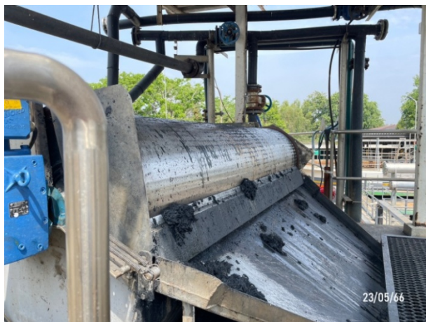
รูปที่ 3-2 ลูกกลิ้งตะแกรงดักขยะ (Bar Screen)
