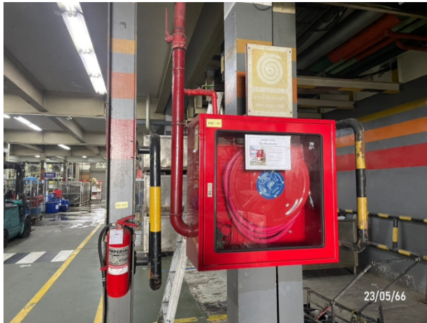
สายฉีดน้ำดับเพลิง (Fire Hose)
